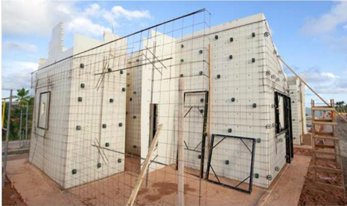
El hormigón celular, fabricado con las materias primas locales y nuestra propias maquinas esta sellado dentro del encofrado. Unas horas son suficientes para esta operación.
